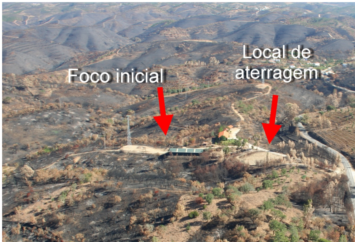
Figura 28 - Vista aérea do local de origem do incêndio e da zona de primeira intervenção
