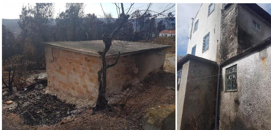
Figura 138 – Exemplos de estruturas em que a parede ficou danificada pelo fogo
