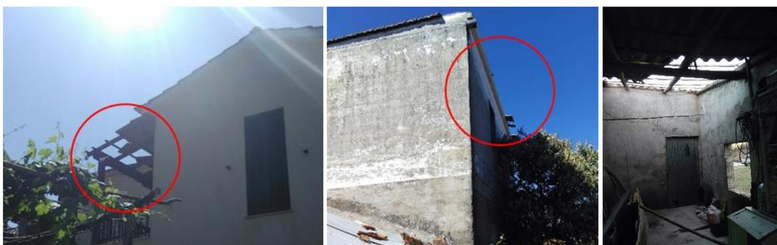
Figura 139 – Pormenores de telhados afetados em estruturas onde não houve ignição
