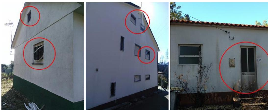
Figura 140 – Pormenores de persianas e outros elementos afetados em estruturas onde não houve ignição
